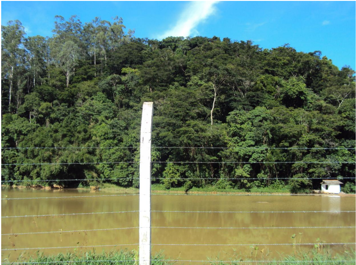
Figura 58 - Usina do Curió
