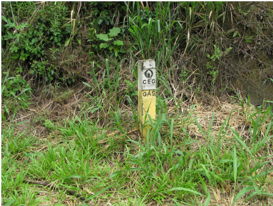
Figura 32 - Totem que marca a localização do gasoduto da CEG inserido na ZA. A foto foi registrada da estrada, o que mostra a proximidade entre a RJ-127 e o gasoduto.
