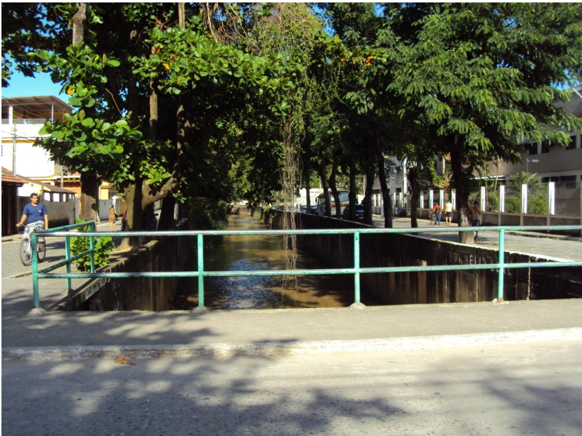
Figura 77 - Rio dos Macacos cruza a área urbana de Paracambi, onde apresenta-se intensamente poluído por esgoto doméstico. Há projeto de canalização deste trecho do rio.
