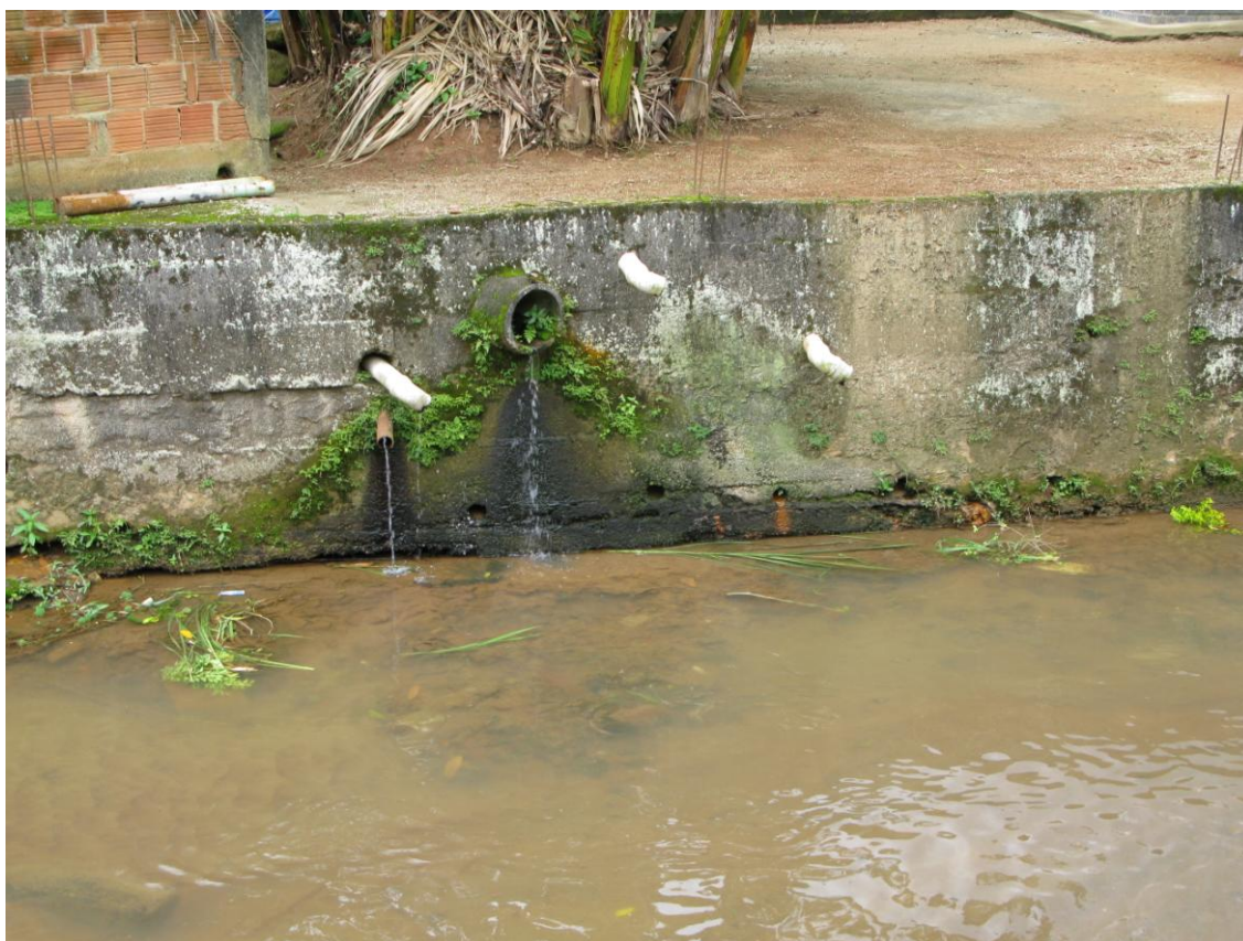
Figura 16 - Foto dos canos por onde as águas pluviais e o esgoto são lançados no Rio dos Macacos. Esta área está situada no município de Paulo de Frontin, no limite com Paracambi e a ZA do PNMCP.
