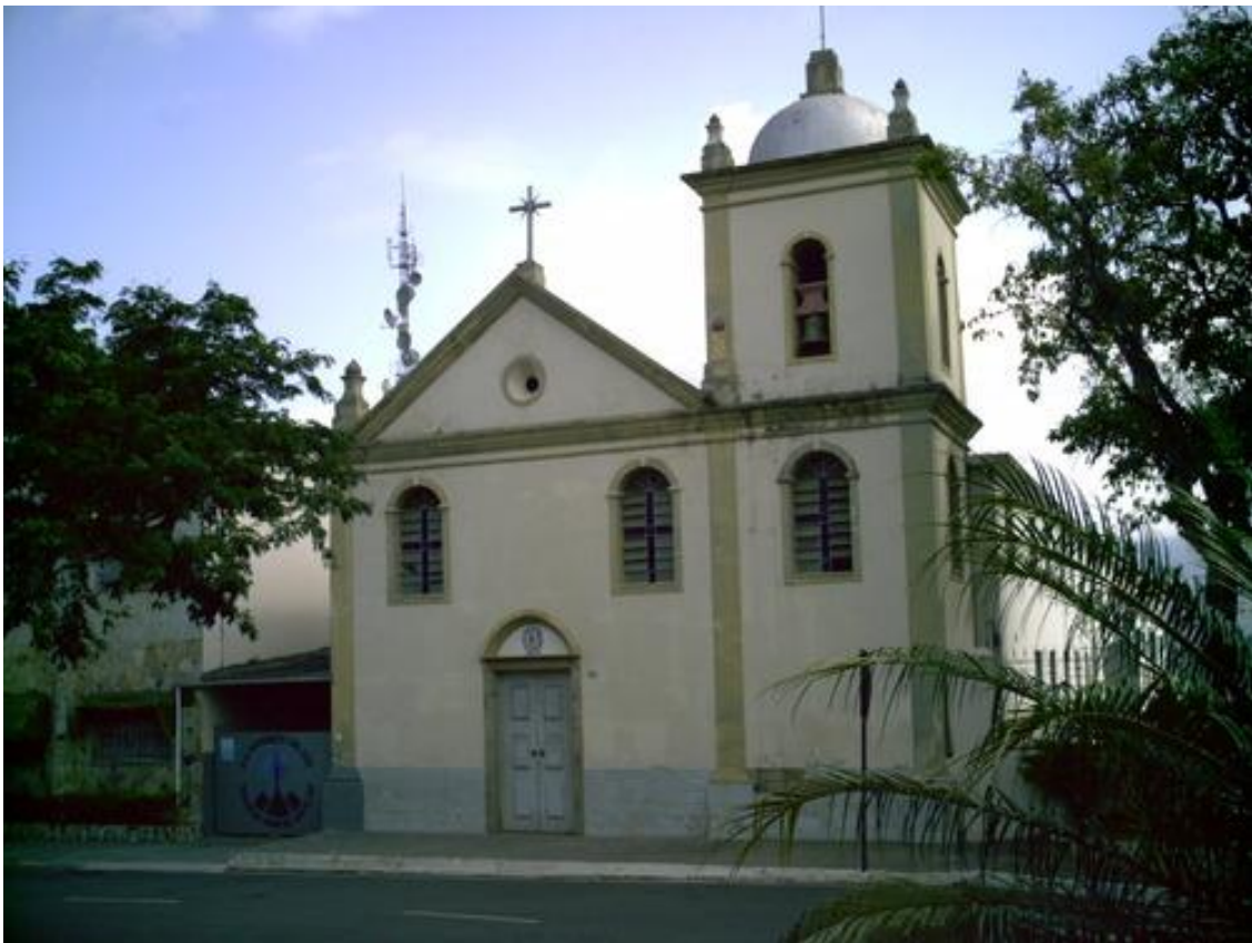
Figura 62 - Igreja de São Francisco Xavier, Itaguaí (Fonte: http://hi.tixik.com/image-215882.htm )
