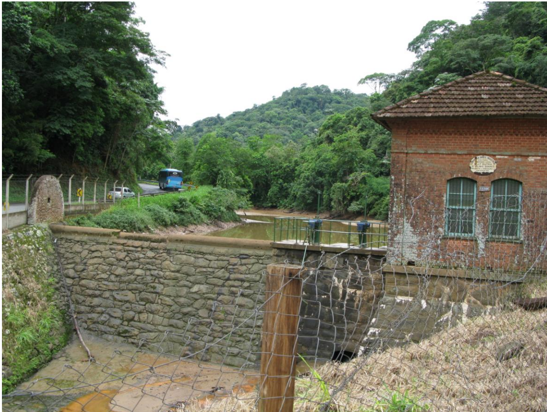
Figura 18 - Usina Palmeira da Serra
