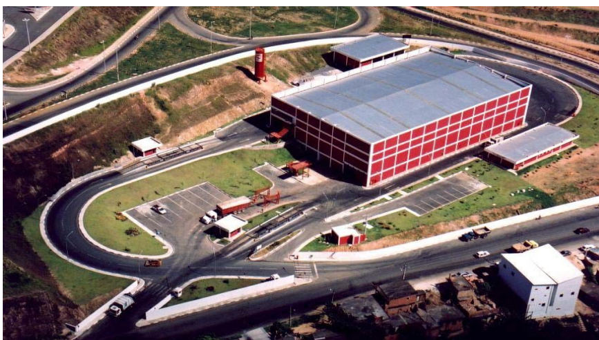
Figura 24 - Estação de Transbordo
