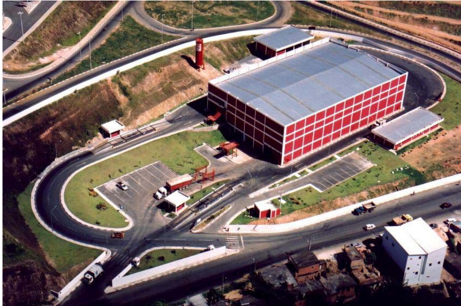
Figura 40 - Estação de Transbordo
